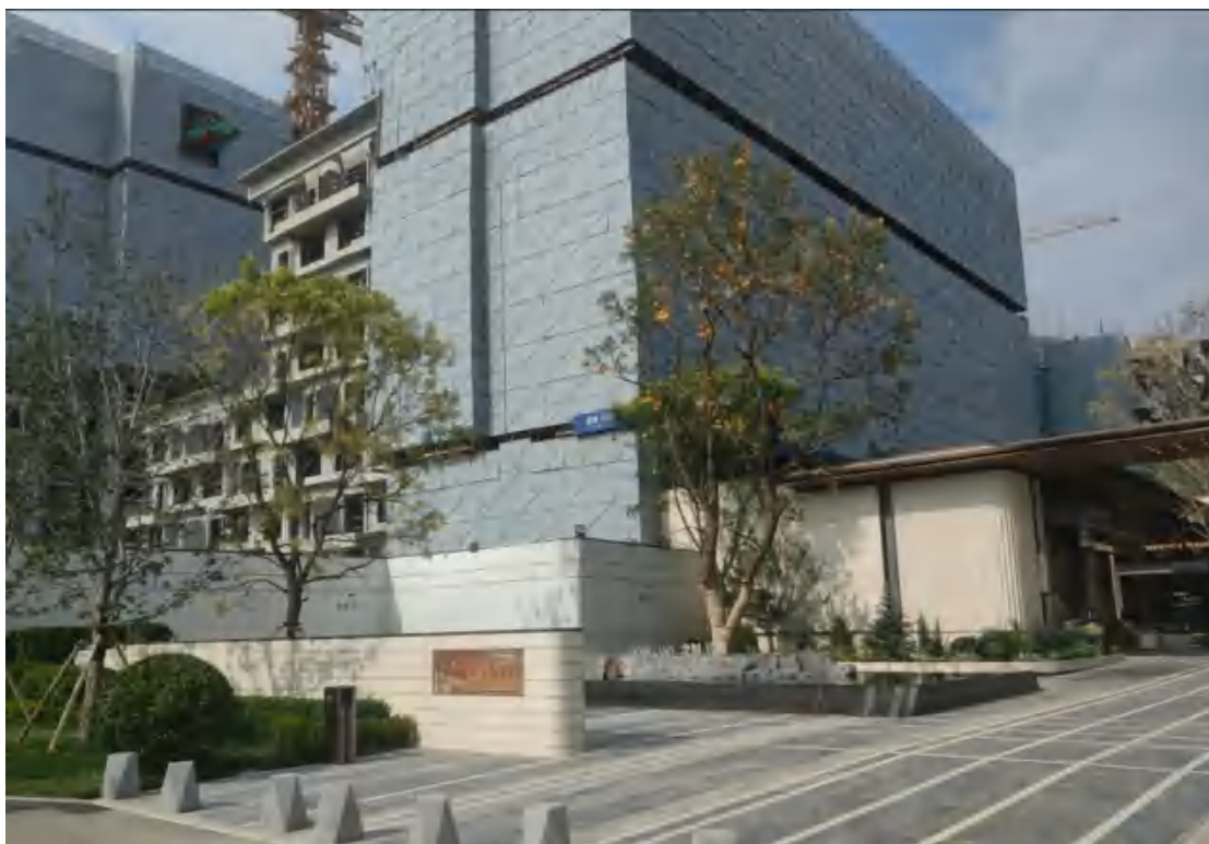
图 3 回创路东侧在建房建项目（2025.7.16）
